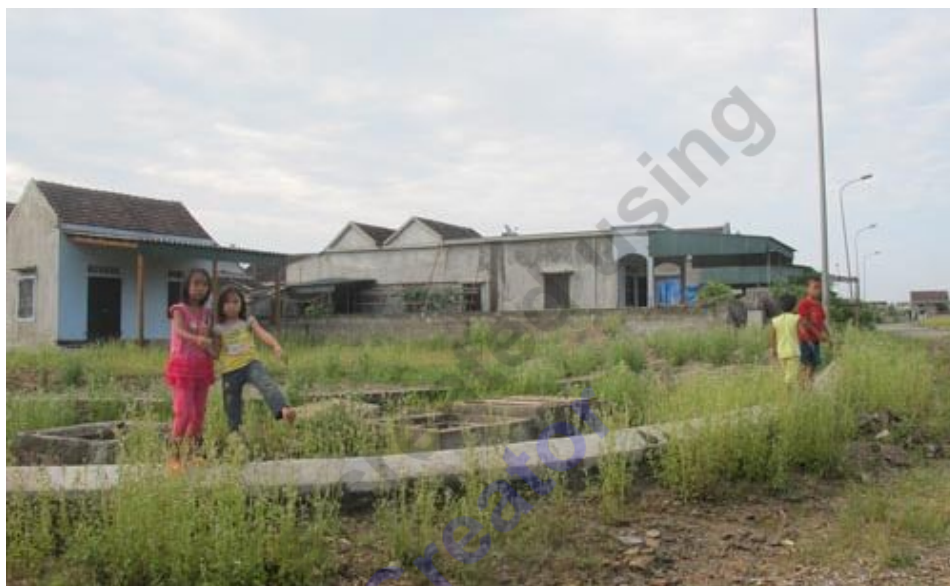
Khu tái định cư của ba con xã Kỳ Lợi ở địa phận xã Kỳ Trinh đang còn dang dở
