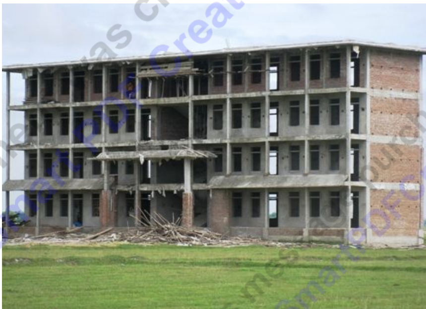
Công trình đồ sộ dở dang, huyện đầu tư hơn 31 tỷ xây trường chờ...giải thể.
