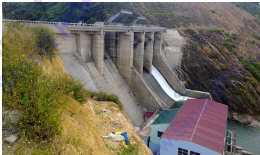
Nhà máy Thủy điện Hồ Hồ đang trong quá trình khắc phục
